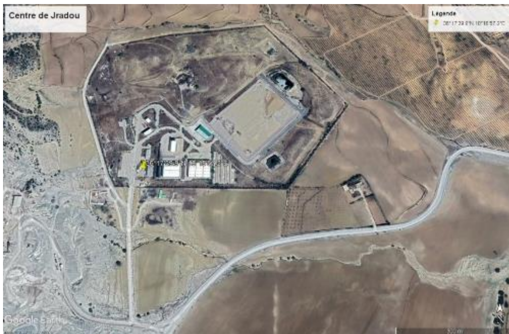
Photo 1 : Vue aérienne de la station de Jradou - Zaghouan
